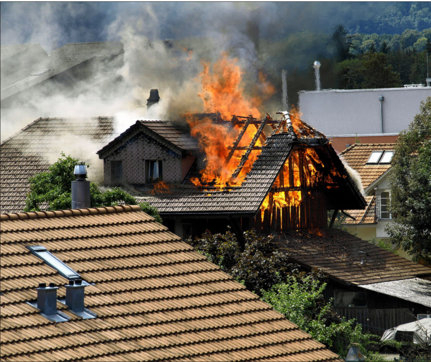
Vollbrand im Dachstock eines Hauses an der Langenstrasse im Thuner Lerchenfeld. Beim Feuer wurde niemand verletzt, die Hausbewohner konnten sich alle selber in Sicherheit bringen.
